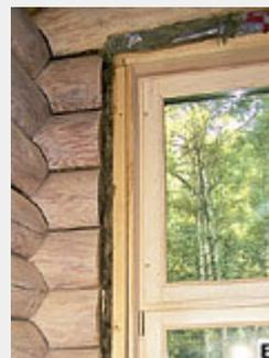
Такая установка окон ничего общего с ГОСТ 30971-2002, регламентирующим этот вопрос, не имеет. Какие там трехслойные конструкции из наружной водопароизоляции, пенного утеплителя и внутренней пароизоляции! Оконные коробки перерублены (а), зазоры заложены досками (б) и заткнуты паклей (в). Мало того, в них еще и электрокабель разместили.
