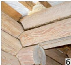
Даже выгиб стен наружу не позволил кровельной конструкции сесть на место. По-видимому, стропила все-таки оторвались от конькового бруса. Об этом свидетельствует широкая щель (а), образовавшаяся между бревнами, составляющими двоянную опорную балку, - "подвинулось" лишившееся нагрузки верхнее бревно (б)
