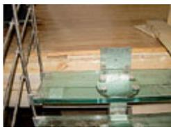
Осевшая конструкция дома согнула металлический косоур (несущую балку лестничного марша, к которой крепятся ступени) лестницы. Как только были убраны крепящие косоур к перекрытию саморезы, лестница "выпрямилась", и даже пластина крепления косоура приподнялась на 1,5 см и вышла на уровень пола
