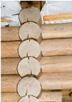
Один из пунктов СНиП "Несущие и ограждающие конструкции" гласит: "Величина зазоров в стыках бревен с одного края не должна превышать 1 мм. Сквозные щели не допускаются". Думается, тем, кто вписал в СНиП эти требования, приведенная на фотографии стена могла привидеться только в страшном сне
