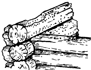
Рис. 36. Конструктивные элементы дома, в первую очередь повреждаемые точильщиками
