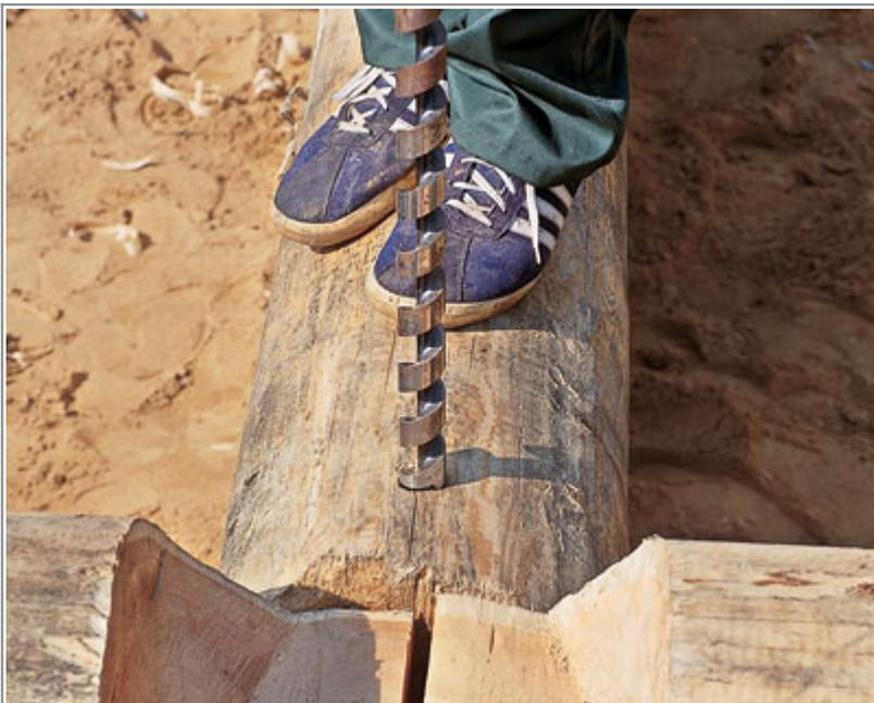
Отверстия под нагели в соседних венцах сверлят строго под размер нагеля. В верхнем бревне рассверливают еще на 2-3 мм, чтобы бревно при усадке не зависало на нагеле
